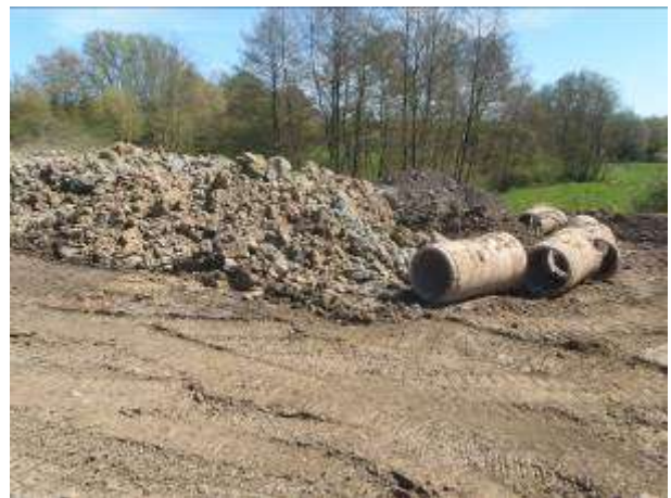
Remise en état des zones de remblais (fin de chantier)
