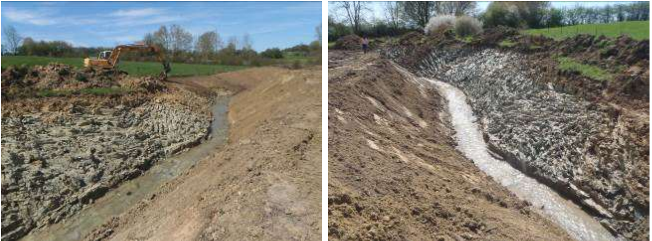
Remise en état de la rive droite en cours
