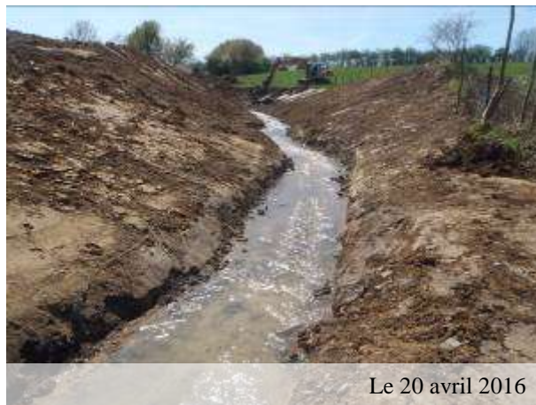
Fin de terrassement de la rive gauche et mise en eau du ru de la Herse (avant et après)
