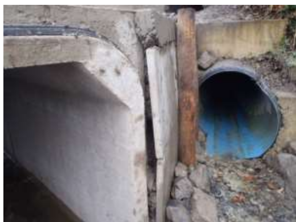
Exutoire réseau pluvial
