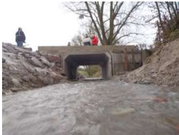
Dalot vue aval
