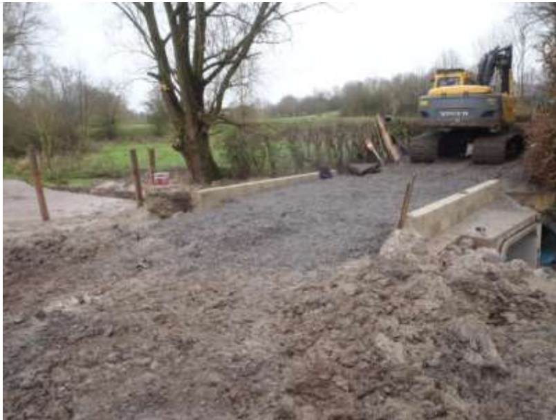
Mise en place du tout venant sur le dalot
