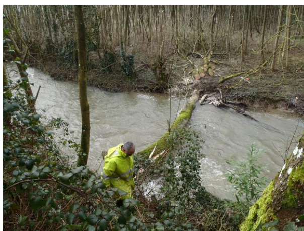
Intervention en cours
