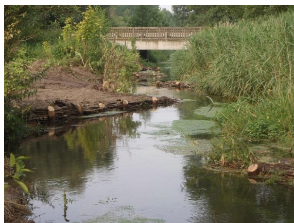
Zone amont après recoupe des pieux et terrassement des banquettes
