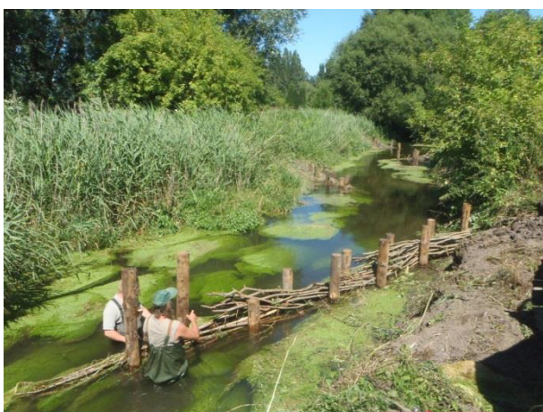
Pose des épis en cours
