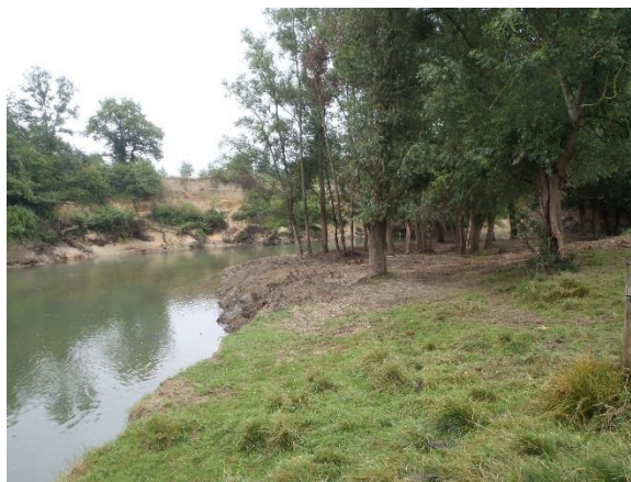
Amas de bois après travaux
