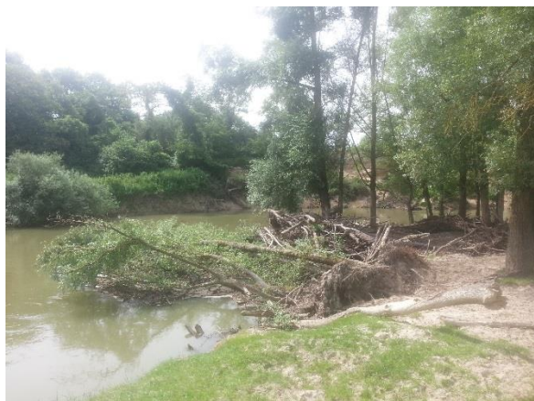
Amas de bois avant travaux (Embâcles 289)
