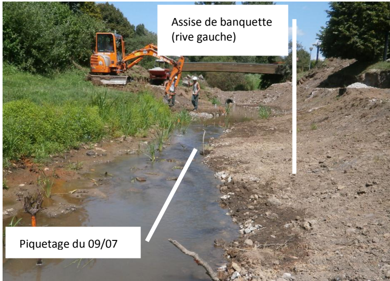
Assise des banquettes (vue vers l’amont)
