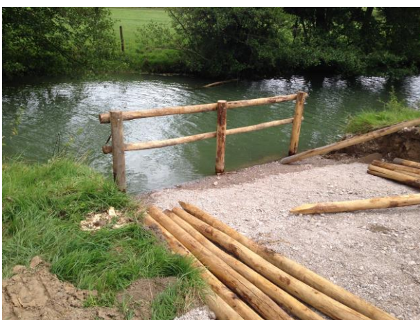
Arrêtes verticales à casser et lisses latérales à fixer
