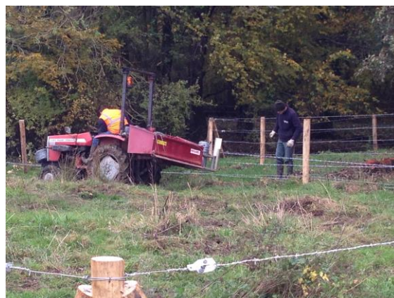
Déroulage et fixation des barbelés en cours
