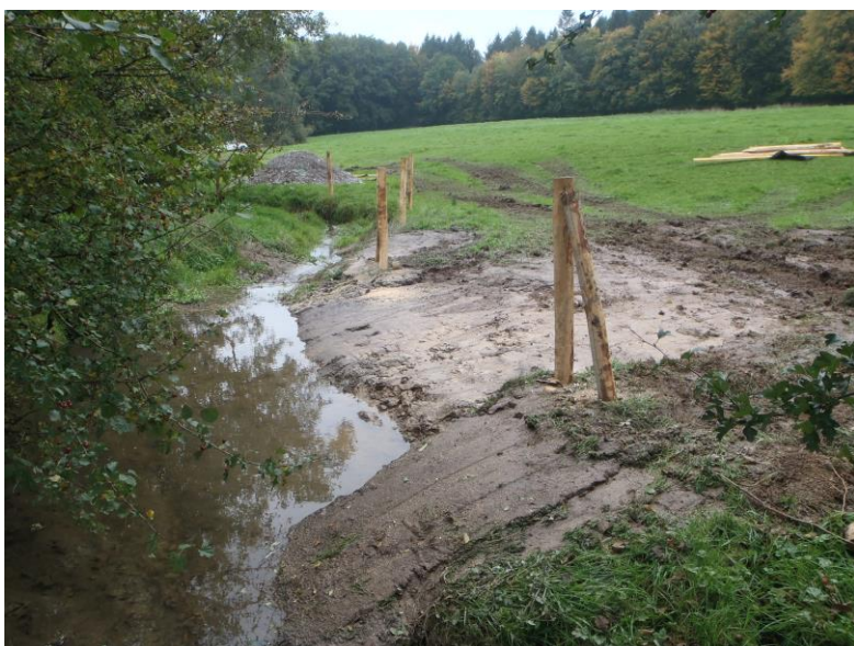
Abreuvoir rustique avant et après talutage de la rive gauche
