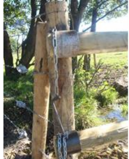
Cloches assurant la fixation des lisses
