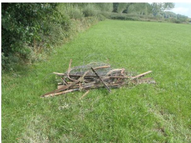
Démontage des anciens baillages
