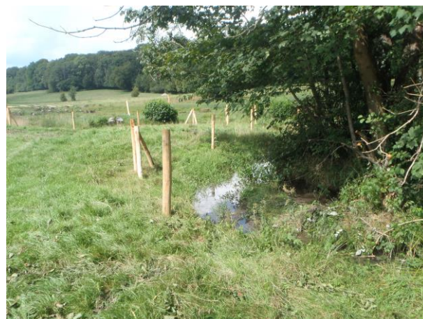
Pose de la clôture en cours
