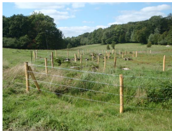
Pose de la clôture en cours
