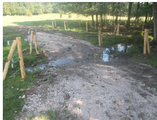
Implantation d'un passage à gué en cours
