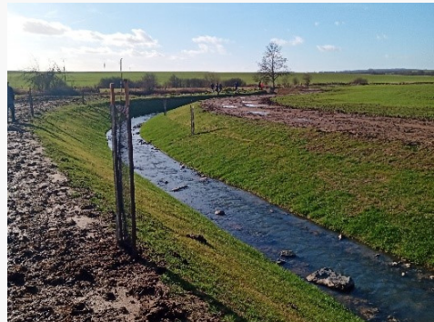
Restauration du lit et des berges
