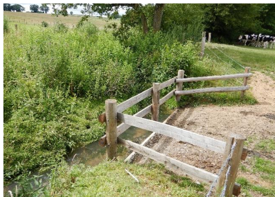
Après la pose de clôtures et d'abreuvoir : reconstitution naturelle d'une ripisylve
