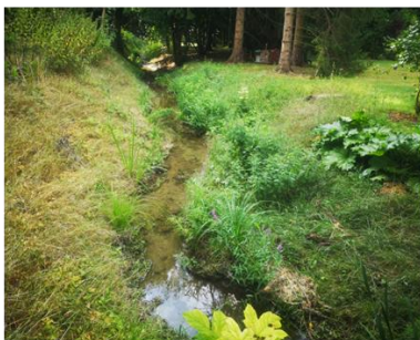
Renaturation de cours d'eau
