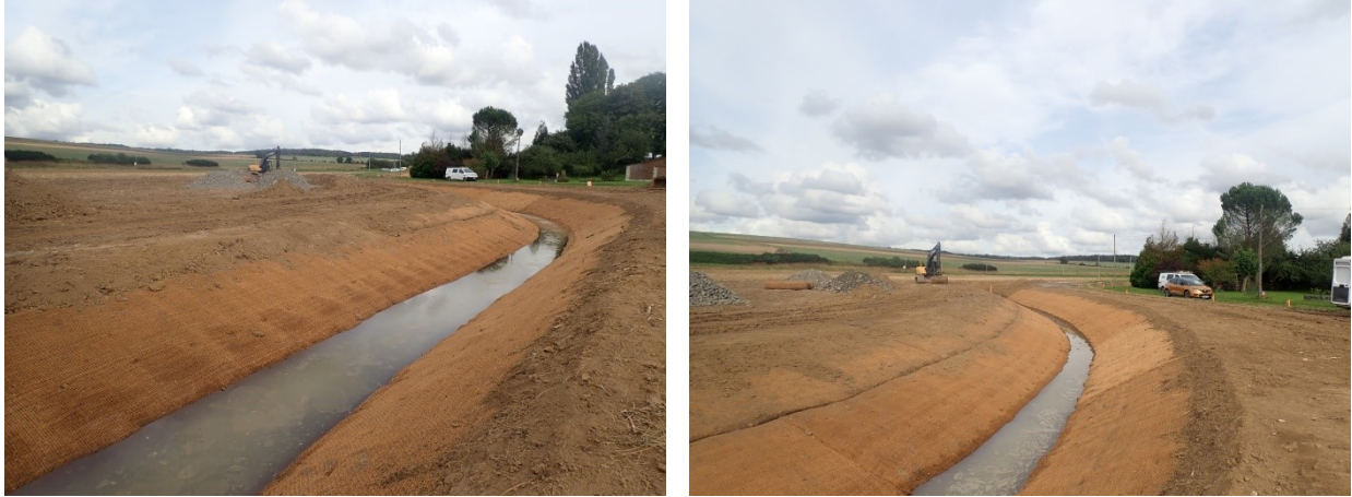
Vues de la section 2 en aval du second pont
