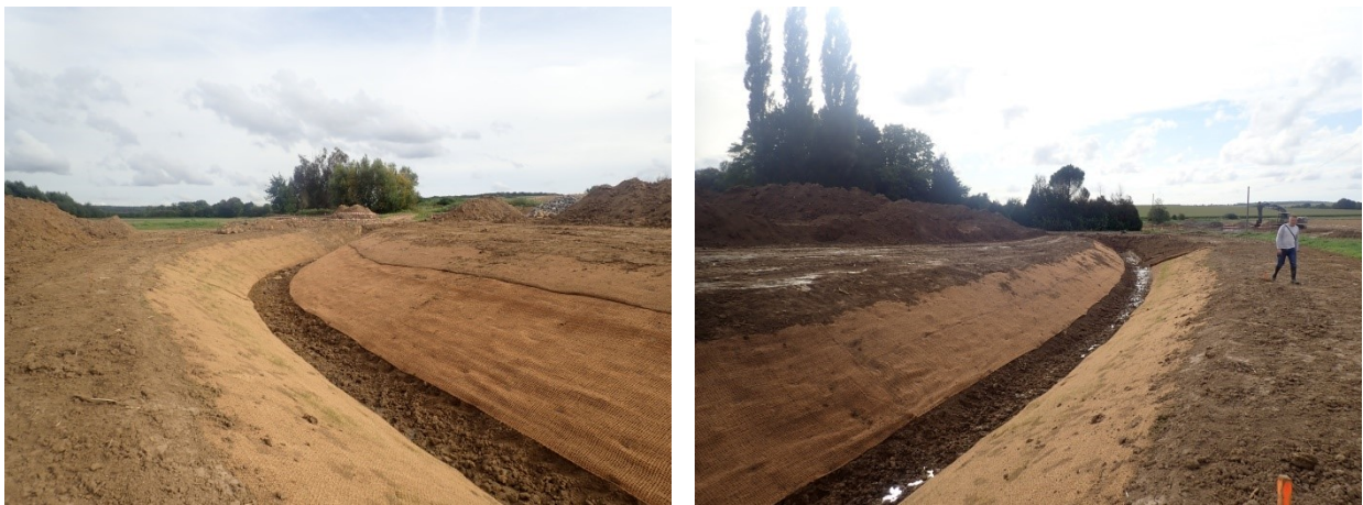
Vues de la berge intrados rive gauche
