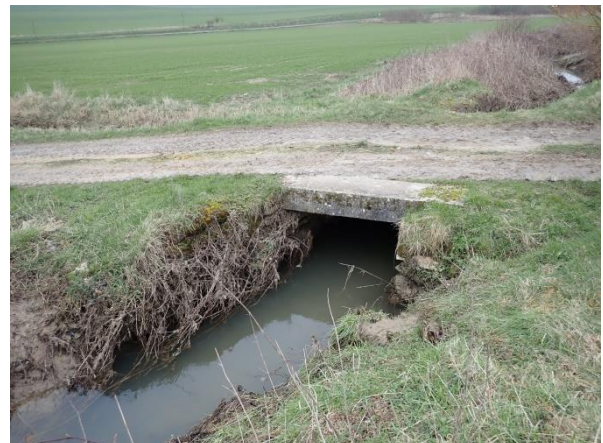
Vue du pont du Ru du Coupé
