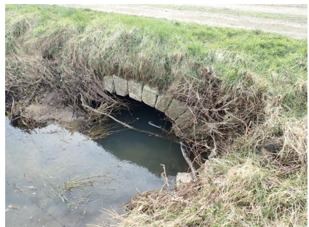
Vue du pont fossé de décharge du Ru du Coupé
