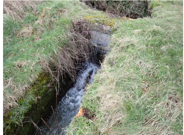
Vue de l'ouvrage
