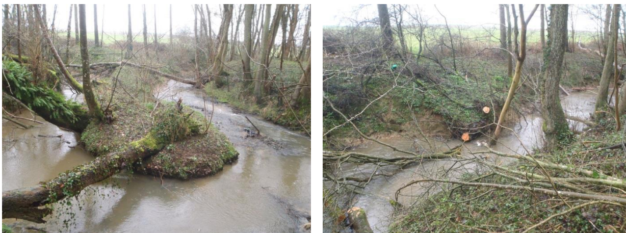
Restauration du lit et des berges du Vilpion en cours
