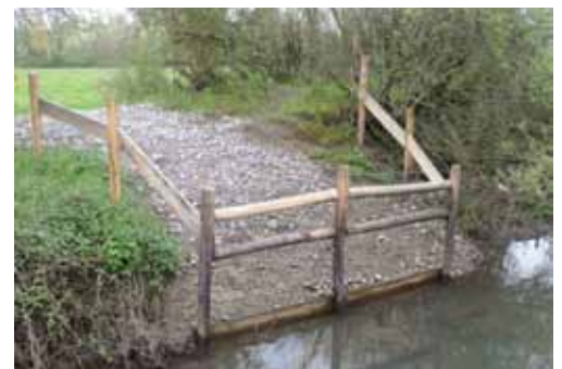
Après travaux : abreuvoir
