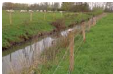
Après travaux : clôtures
