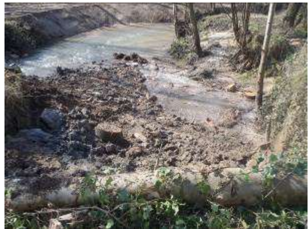
Comblement partiel de la fosse du seuil S1
