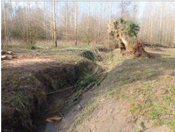
Mise à sec du bras d'amenée
