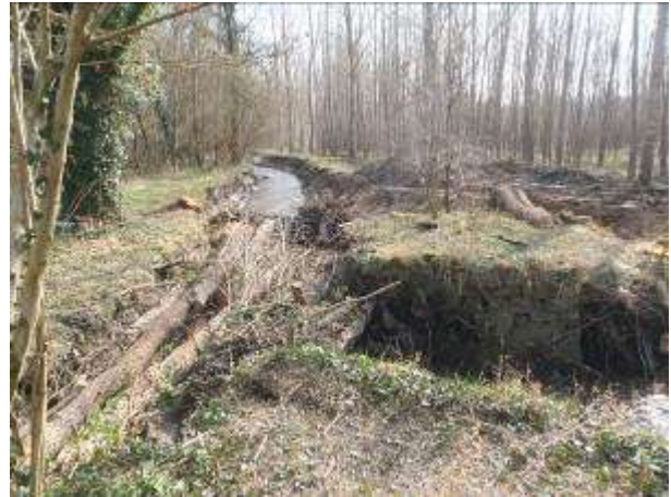
Matérialisation de zones de talutage
