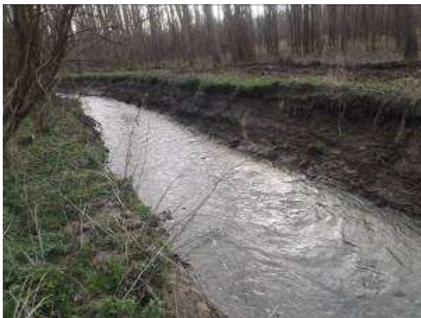
Baisse du niveau d'eau en amont de l'ancien seuil et stabilisation du lit
