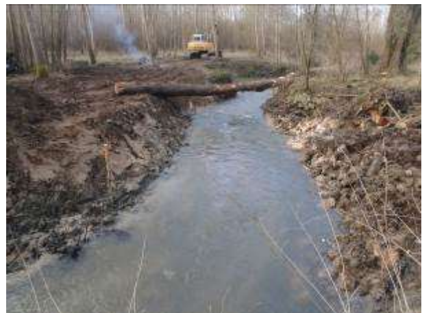
Emplacement de l'ancien seuil et comblement du bief en rive droite
