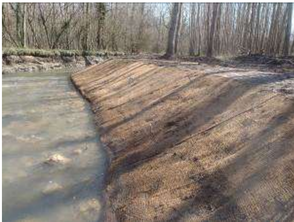
Talutage et pose de géotextile en rive gauche
