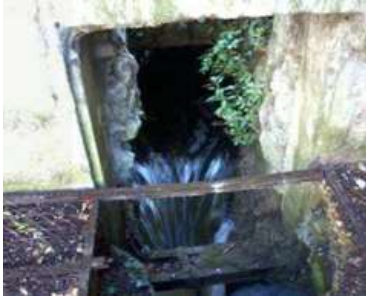
Seuil activant la roue (S2)
