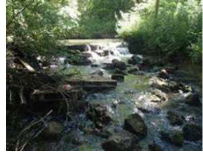
Déversoir latéral (D1)
