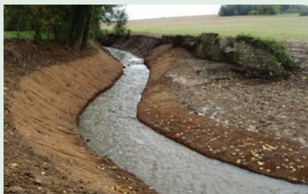
Site du moulin Canard à la fin des travaux (novembre 2013)
