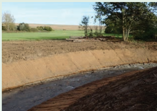
Site du moulin Vert à la fin des travaux (novembre 2013)
