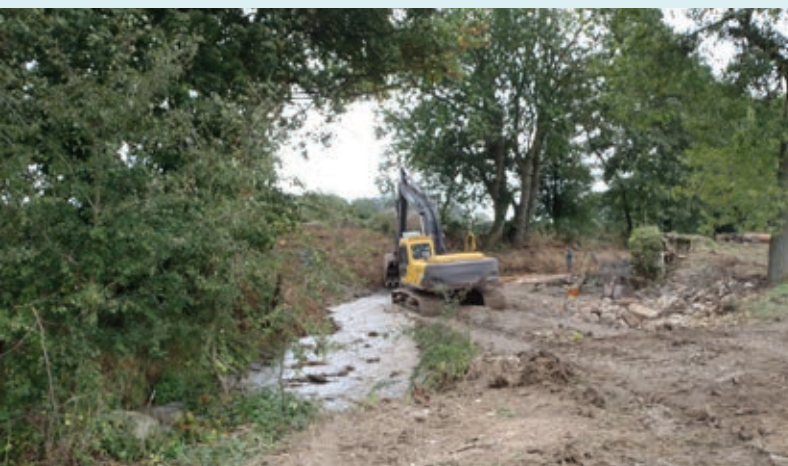
Travaux de dérasement du seuil du moulin Canard (octobre 2013)
