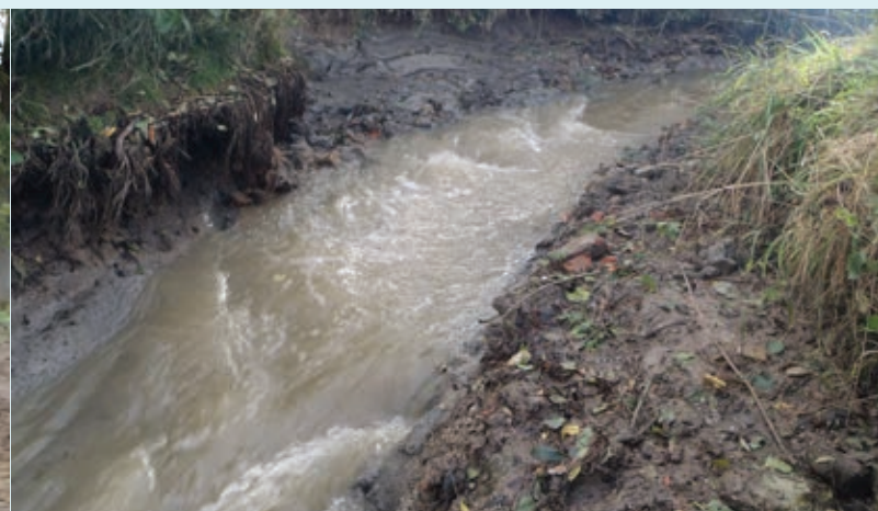
Seuil du moulin Vert après son dérasement (novembre 2013)
