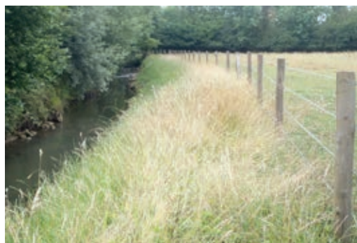
Clôture en haut de berge au niveau du moulin Vert
