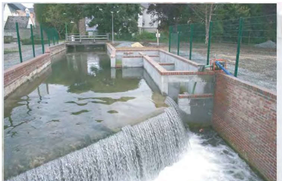
Continuité écologique par réalisation de 3 rampes rustiques à macrorugosités sur les seuils de l'ancien barrage de Kernansquillec sur le fleuve Léguer à Plounévez-Moëdec - ComCom Belle-Isle-en-Terre (22) - Maîtrise d'oeuvre RCE CE3E 2012-2013
