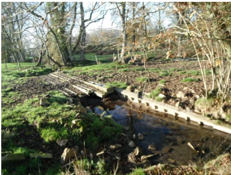
Figure 53: Protection de berges en poteaux EDF
