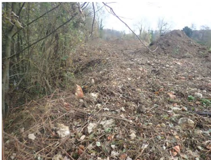
Figure 22 : Remblaiement en zone humide Bergères sous Montmirail.
