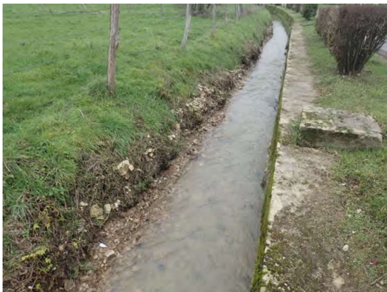
Figure 31 : Erosion de berge liée à l'incision en aval de Boissy-le-Repos
