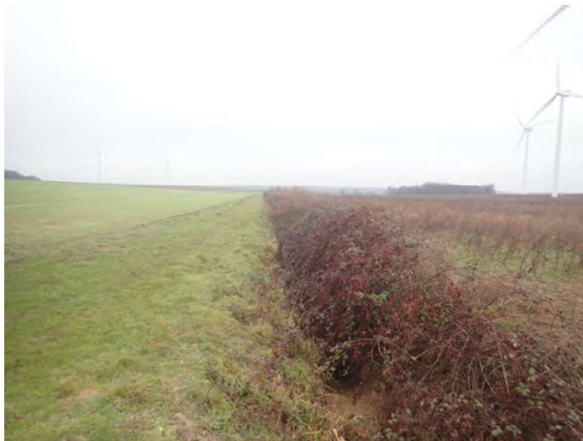
Figure 49: Fossés d'Egremont au niveau des éoliennes
