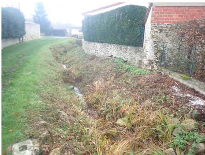
Figure 54: Altération du cours d'eau à Viels Maison
